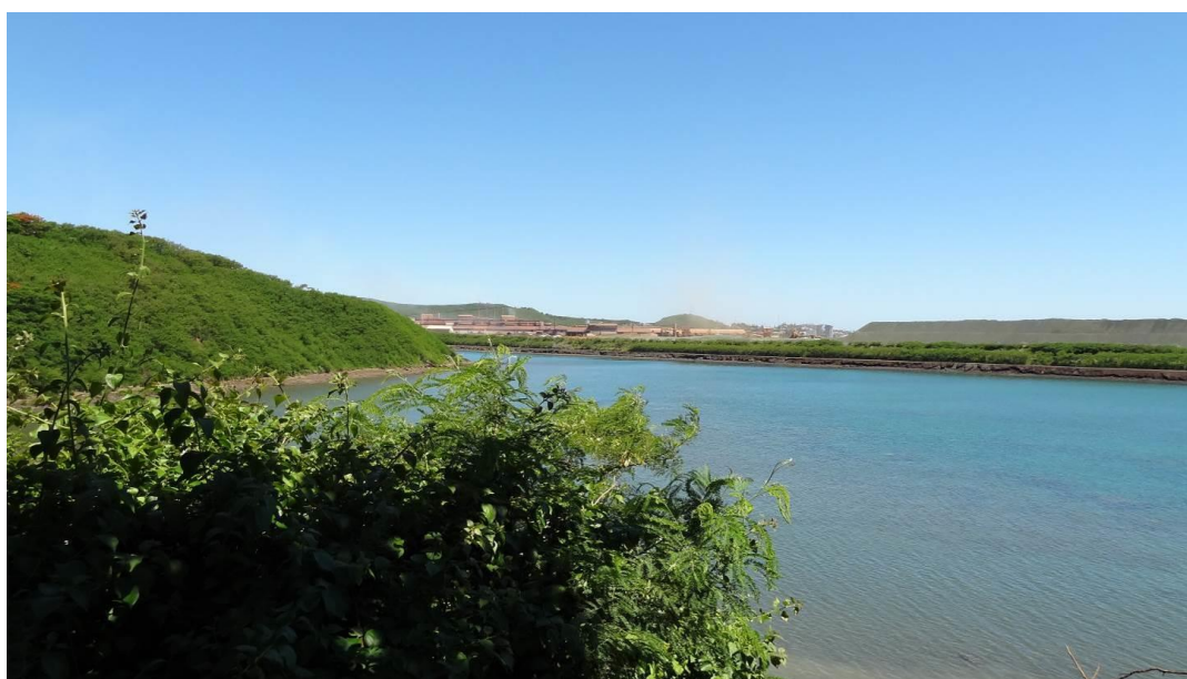
Figure 4: Vue de l'usine depuis le site de mesure
