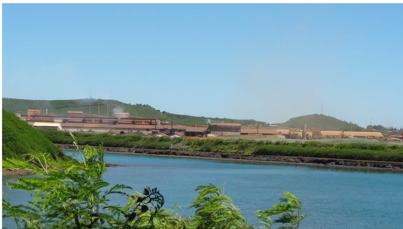
Figure 1 : Vue zoomée de l'usine depuis la rue de Papeete
